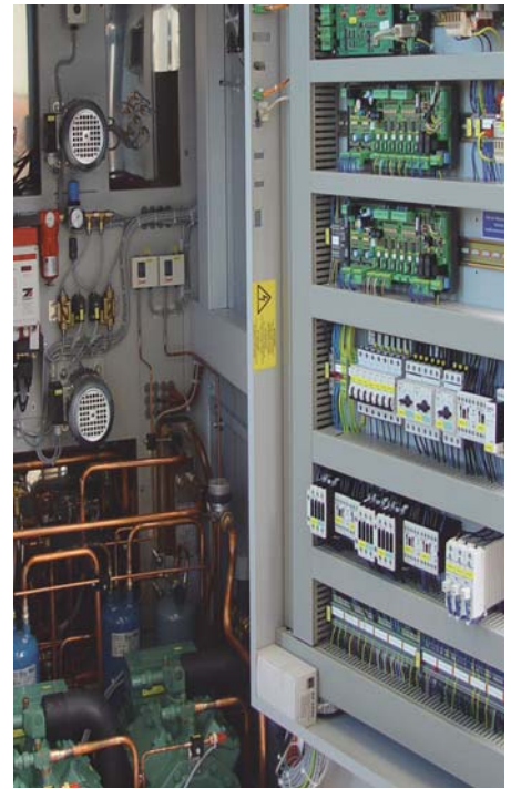
Bild 3: CTS verbaut generell den Halbleiter- schütz-Typ 3RF23 bis 25 A Bemessungsstrom
