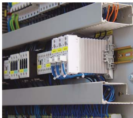
Bild 4: Die angepassten Kühlkörper machen aus den Halbleiterrelais Halbleiterschütze
