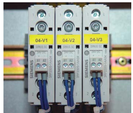
Bild 5: Über die Anschlüsse A1 und A2 wird der Halbleiterschütz von der Anlagensteue- rung ge-schaltet, hier mit einer Steuer- spannung von 24 V DC
